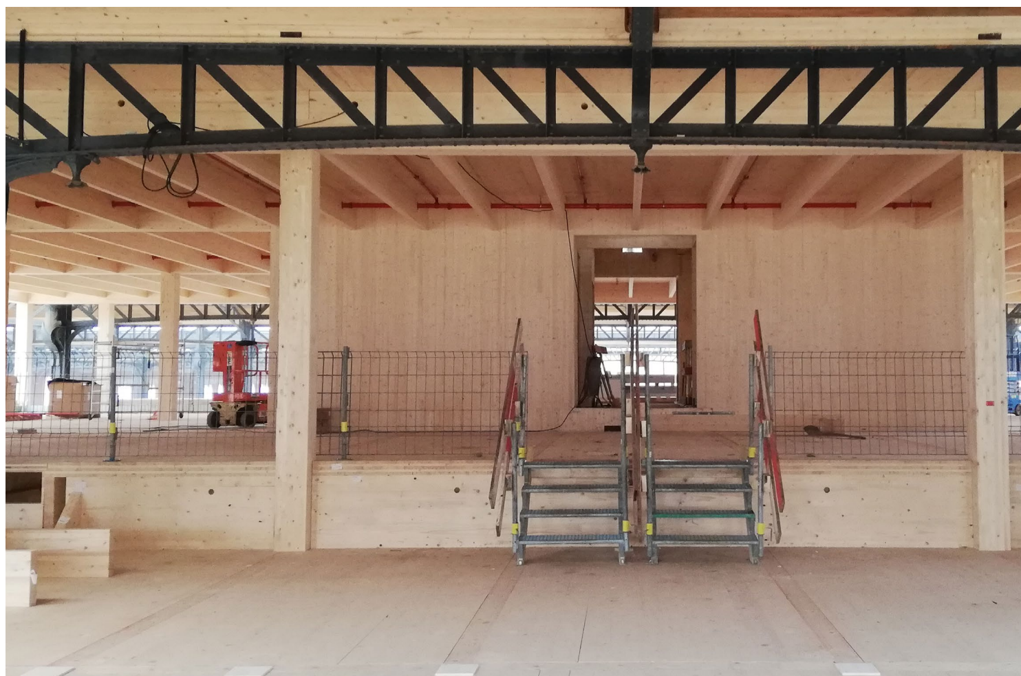
Gare Maritime - Tour et Taxis - Bruxelles
